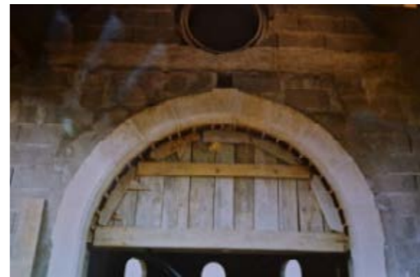
Coffrage de la porte d'entrée réalisé avec un fond de cuve de fermentation de vin en bois.
